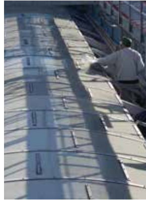
⑦商店街アーケード 屋根清掃作業
